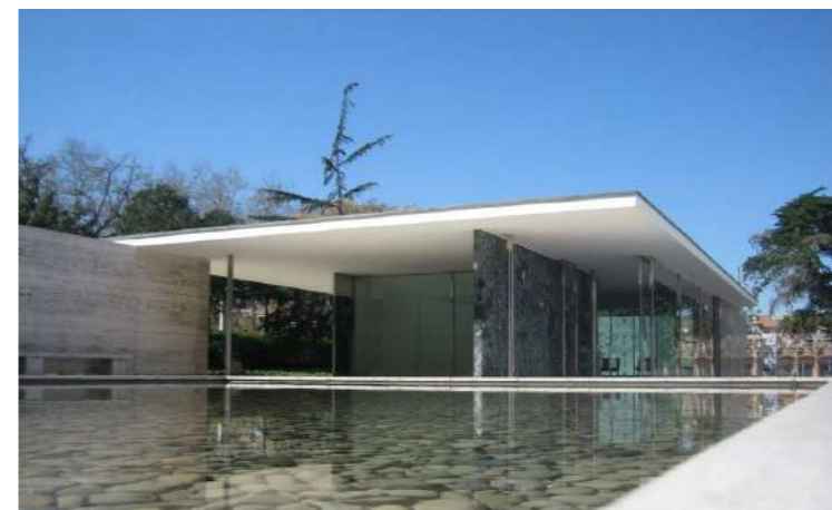
Fig. 6. Pavillon de Barcelone, Mies van der Rohe, 1929 [reconstruit 1983-1986].
