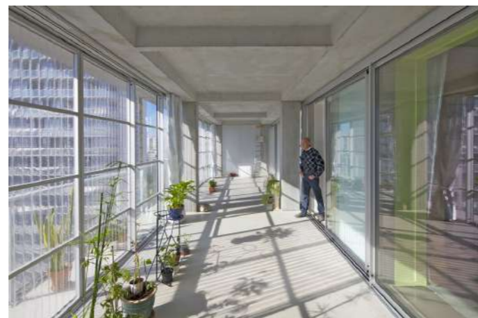
Fig. 9. Transformation de 530 logements, quartier du Grand Parc, Bordeaux, Lacaton et Vassal, 2017
